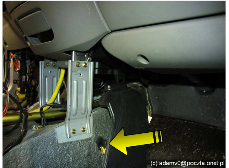
W tym miejscu przewód jest skleiony, trzeba to podgrzać żeby oderwać
