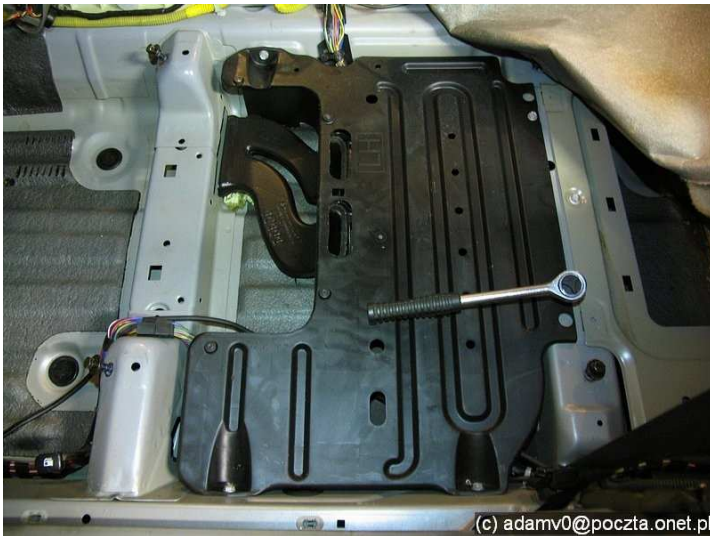
Teraz pora na plastikowe mocowanie wylotów nawiewu
